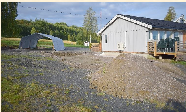
Slik så det ut på byggeplassen 18. september 2017.
