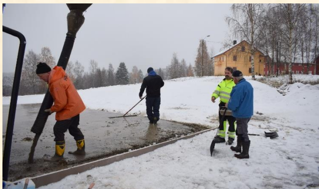
Den 25. oktober 2017 ble «plata» støpt. Fra venstre: Ragnar Einarsrud og Per Anders Magnes legger ut betongen, mens sjåføren fra Betong Øst og Sigmund Tørraasen kontrollerer at alt går som det skal.
