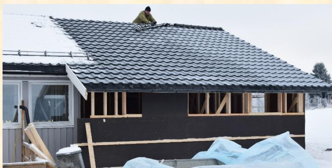
Det nærmer seg jul og den 5. desember 2017 ble siste plate lagt på yttertaket og vindplatene på veggene på plass
