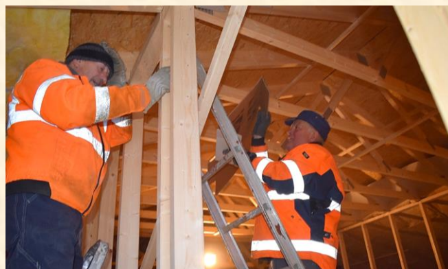
Og den 11. januar var man i full gang med isolasjon av tak og vegger. Her Einar Finstad og Sigmund Tørraasen i arbeid.
