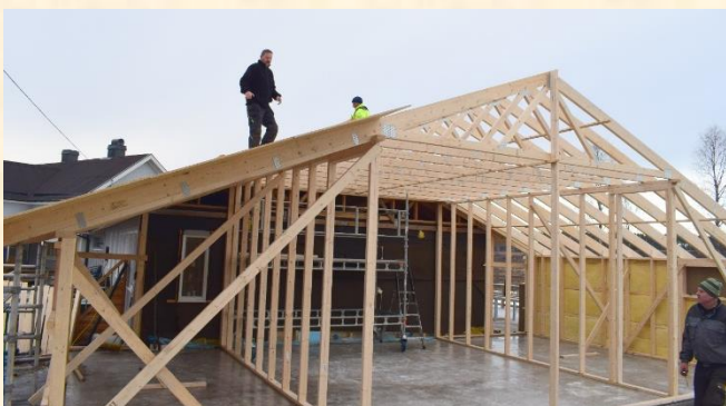
To måneder senere, 18. november 2017, begynte bygget å ta form. På taket fra venstre: Terje Frydenlund og Per Arne Pedersen. Helt til høyre: Erling Olav Eriksmoen.
