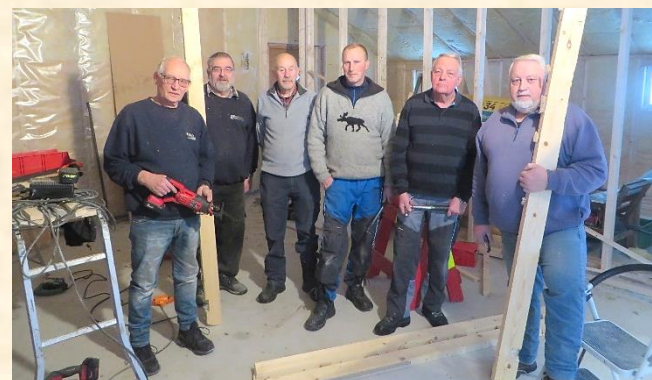
Isolasjonsarbeidet er ferdig og arbeidet med selve scenen er i gang. Her er noen av dugnadsgjengen samlet 25. januar 2018, under en måned til Teater innlandet skal på scenen. Fra venstre: Svein Erik Grandahl, Jan Ivar Sparby, Einar Finstad, Sigmund Tørraasen og Arne Idar Grandahl.
