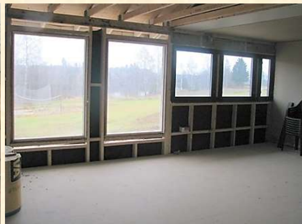
På veggen mot Glomma ble det satt inn to store vinduer.
