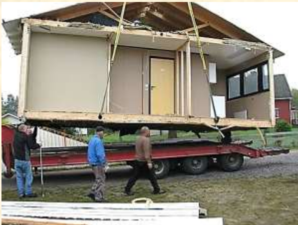
Den første modulen klar for transport til Grendetunet.
