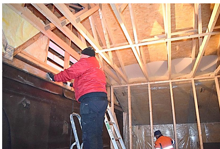
Rolf Gunnar Osrønningen i ferd med å isolere deler av vegg mellom salen og scenebygget. Sigmund Tøraasen i bakgrunnen, under det som skal bli «lager». Det svarte feltet under er det som senere skal bli åpningen mellom scenen og salen.
