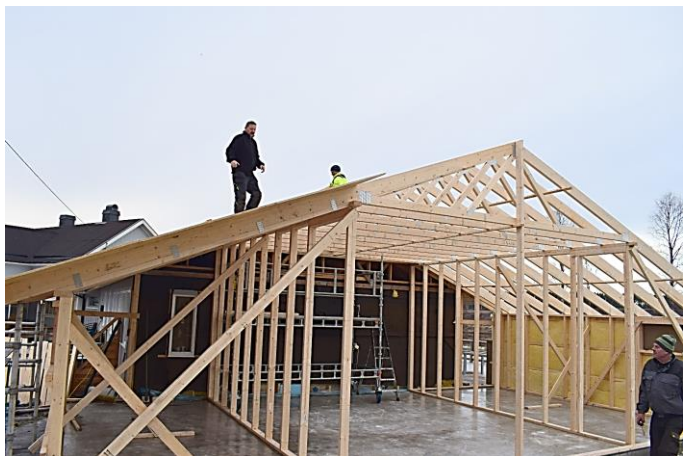
Den 18. november var man i gang med å legge undertaket. På taket Terje Frydenlund og Per Arne Pedersen. Erling Olav Eriksmoen til høyre, utgjorde deler av «bakkemannskapet».
