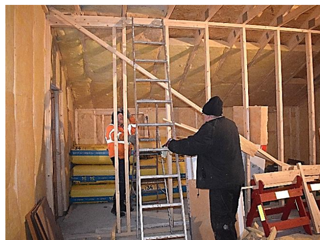
Taket over det som skal bli «garderobe» får lagt nødvendig isolasjon. Jahn Ivar Sparby ved stigen og Einar Finstad i bakgrunnen.
